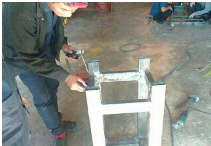
ภาพที่ 12 ขึ้น โครงสร้างเครื่องบดผสม
