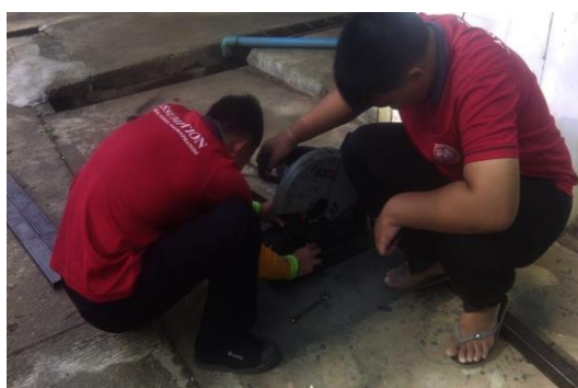
ภาพที่ 8 ตัดเหล็กให้ได้ขนาด
