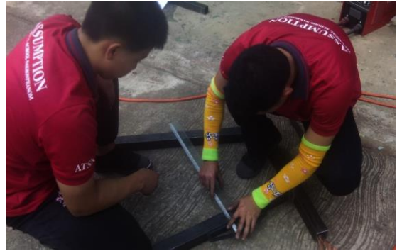
ภาพที่ 13 ทำโครงสร้างของแม่แรง
