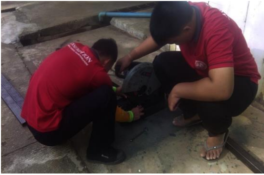
ภาพที่ 12 ตัดเหล็กทำตัวต่อด้านบนของโครงงาน
